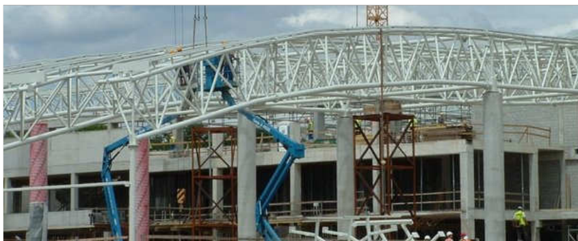
Prace na budowie Term Maltańskich (© Materiały prasowe)
